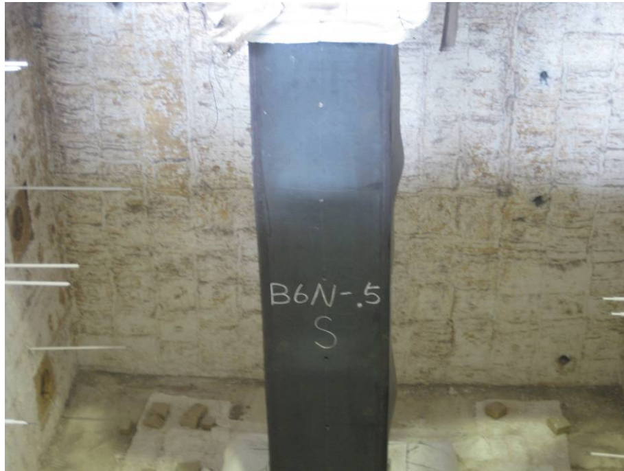
照片3：試驗後試體破壞情況(I)
