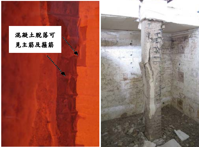
(a) 火害中 (b) 火害後 圖7 試體SCC1-SC火害照片
